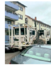
Vibro-Truck auf einer engen Straße. Foto: Privat
